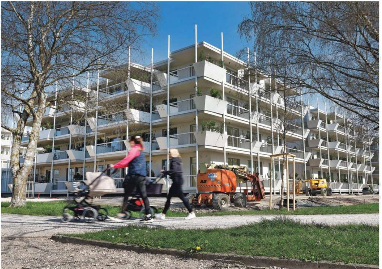
Na nadaljnjo rast stroškov dela bosta vplivala tudi zadnji dvig minimalne plače na tisoč evrov neto ter pomanjkanje kadra v gradbeništvu. FOTO LEON VIDIC
